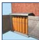
Si en tu instalación dispones de botellas de 35 Kg, como norma general, han de estar siempre en el exterior de los edificios, viviendas o locales y se protegen con una caseta de material incombustible.
